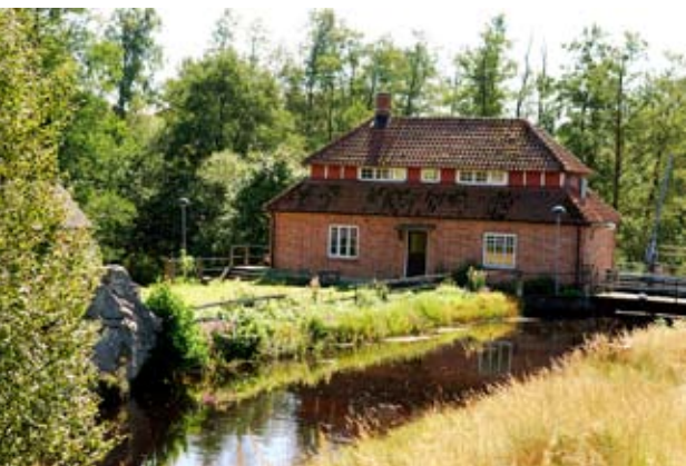
Gonarps kraftstation. Foto: Tobias Delfin.
